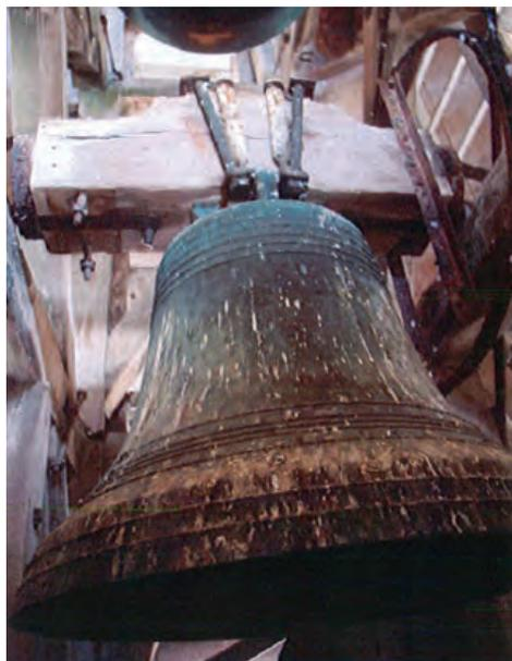
Pour les cloches elles-mêmes, une restauration nécessaire serait la modification du mouton. Aussi appelé joug, c'est la pièce qui soutient la cloche et permet sa mise en volée. Il est fabriqué sur mesure en fonction du poids de chaque cloche.
